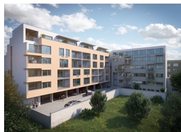
dvorní část pohled směr jiho-východ
